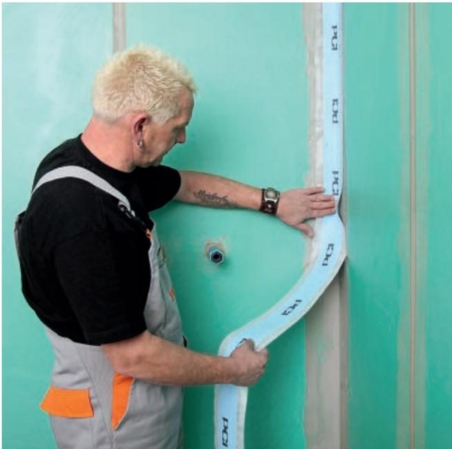
3. Зафиксировать PCI Resitare120 с помощью PCI Lastogum (серого цвета) в угловых соединениях и соединениях пола со стенами.
