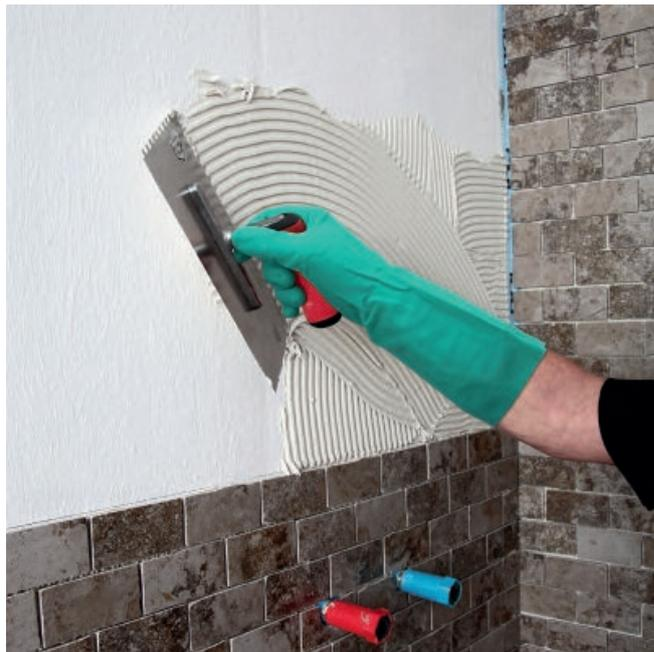
6. Перед укладкой плитки и каменных плит слой PCI Lastogum должен просохнуть
