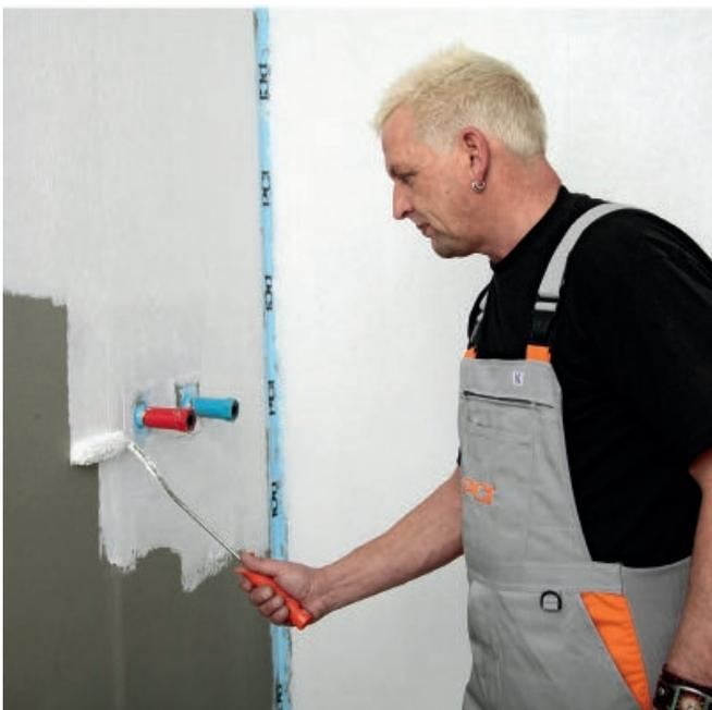
5. Нанести второй защитный слой PCI Lastogum (белого цвета), выждав время набора необходимой прочности (прибл. 1 час). Первый слой PCI Lastogum (серого цвета) не должен просвечивать, иначе потребуются еще один слой.
