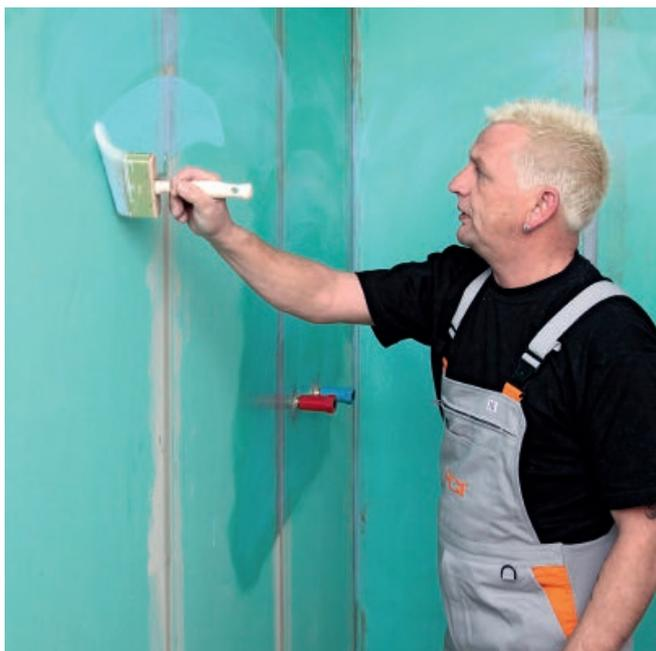
1. Для обработки впитывающих минеральных поверхностей или материалов и плит на основе гипса использовать грунтовку PCI Gisogrund или MasterTile P300.
