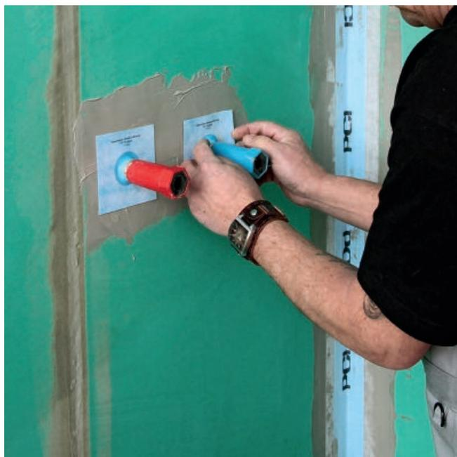
2. В местах прохождения труб через стену поместить PCI Pesticape 10×10 и покрыть составом Lastogum PCI (серого цвета).
