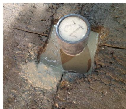
PCI Repaflow имеет жидкую консистенцию, удобен в применении
